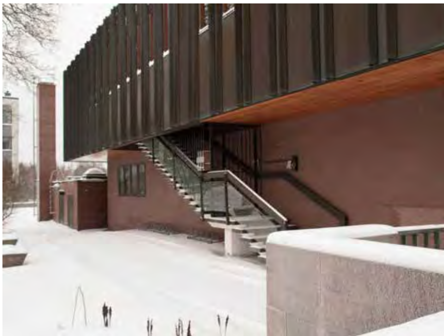
Rakennuksen pihasivulle antavat ilmettä toiseen kerrokseen sisäpihalle johtavat portaat. Ensimmäisen kerroksen julkisivuissa on punagraniittipinta ja toisen kerroksen ulokkeen alapinnalla oregonmänty-laudoitus. Kattilahuoneen savupiipun vieressä näkyvä välinevarasto on 1970-luvulla tehty lisäys.
