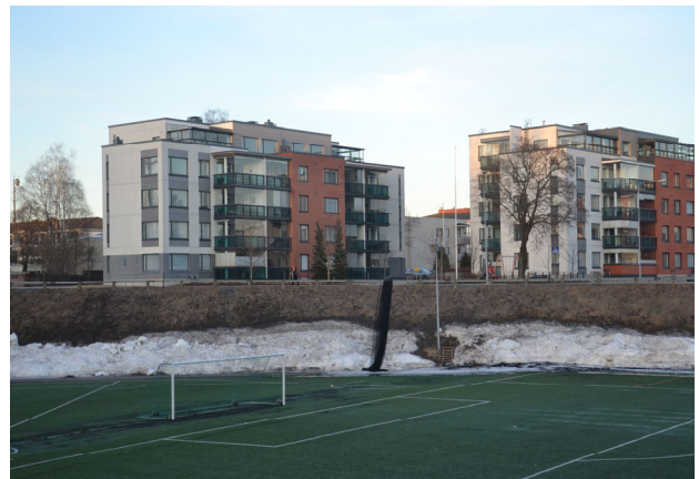
4. Vuonna 2007 rakennetut viisikerroksiset kerrostalot
