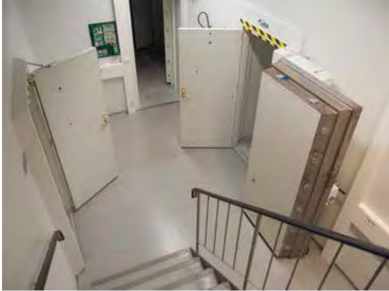
Kellarikerroksen "eteinen" K002 ensimmäisestä kerroksesta laskeutuvine portaineen. Oikealla entisen pankkiholvin ovi, jonka aukkoon on lisätty puolustusvoimien aikaan laakaovi käyttöoveksi. Vasemmalla alunperin arkistona olleeseen tilaan johtava ovi, johon myös on lisätty käyttöovi, taustalla väestönsuojan ovi.
