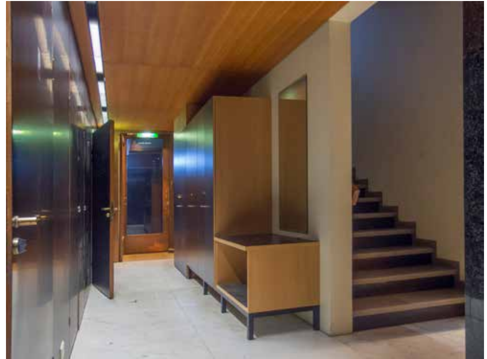
Pankin tilojen takaosassa oleva käytävä 110b. Lattia on marmoria, seinissä, ovissa ja kalusteissa laminaattiverhous, osa seinistä on tasoitettuja ja maalattuja. Oikealla näkyy toiseen kerrokseen johtava porras.
