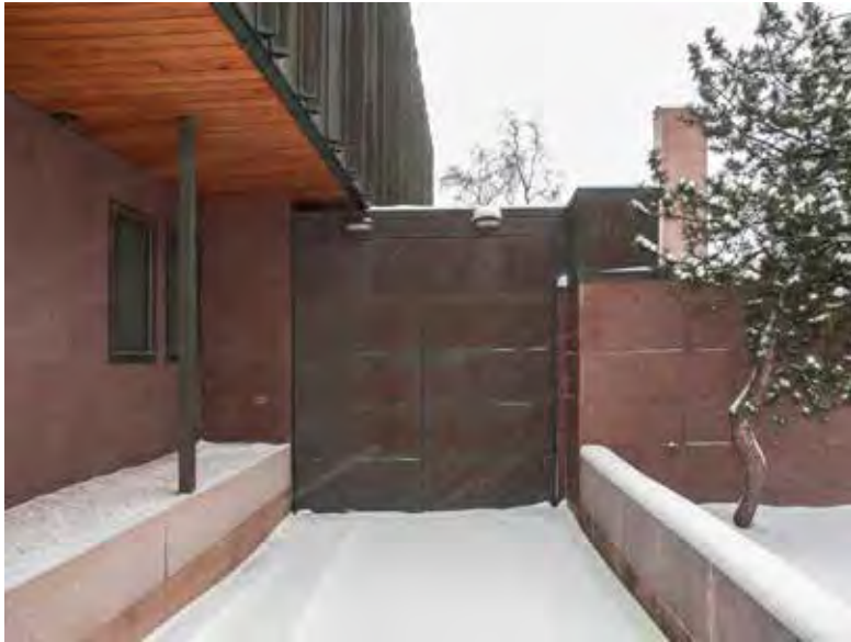
Päiviönkadun puolella oleva lastaustilan ovi, jonka kautta raha-autot pääsivät sisäpihalle. Nykyinen ovi ja sisäpihaosan vesikatto ovat peräisin 1976 tehdystä muutoksesta.
