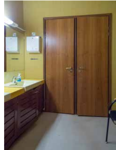
Wc 116, jonka nykyinen asu on pääosin peräisin 1970-luvun muutoksista.
