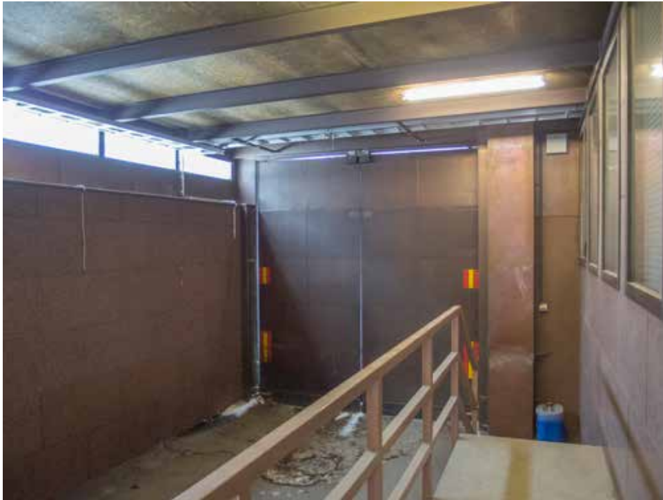
Lastauspiha 120, joka alkujaan oli kattamaton. Katto ja yläikkunat tehtiin vuonna 1977, samalla ovi uusittiin.
