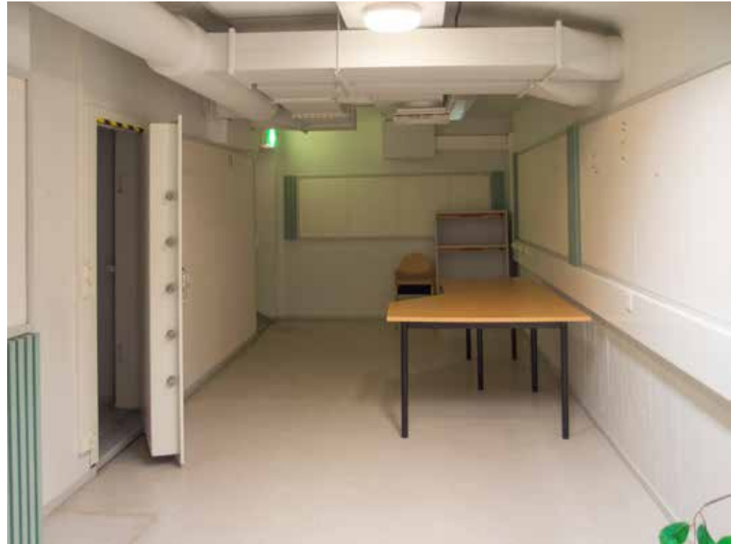
Väestönsuojan suojahuone K008 nykyasussaan.
