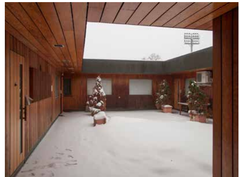
Toisen kerroksen tasolla oleva atriumpiha oli kaupunkioiloissa ainutlaatuisen, intiimi asuntojen sisäpiha.
